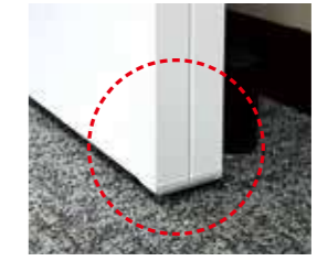
フットガード ドアの下端には靴などが傷つかないよう、樹脂製のフットガードが付いています。
